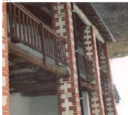
151. particolare di pilastri in pietra e mattone tipici dell'area della bisalta
